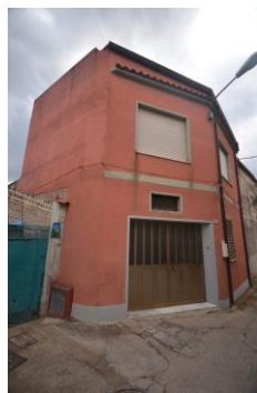
Vista da Via Cagliari
