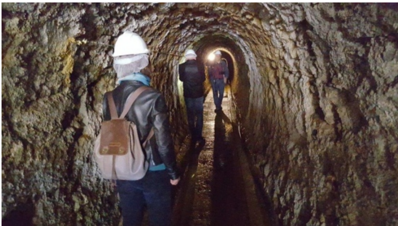
Foto - Galleria Anglo-Sarda nell'area di Pozzo Sartori ('800 primi '900), con sezione ellittica
